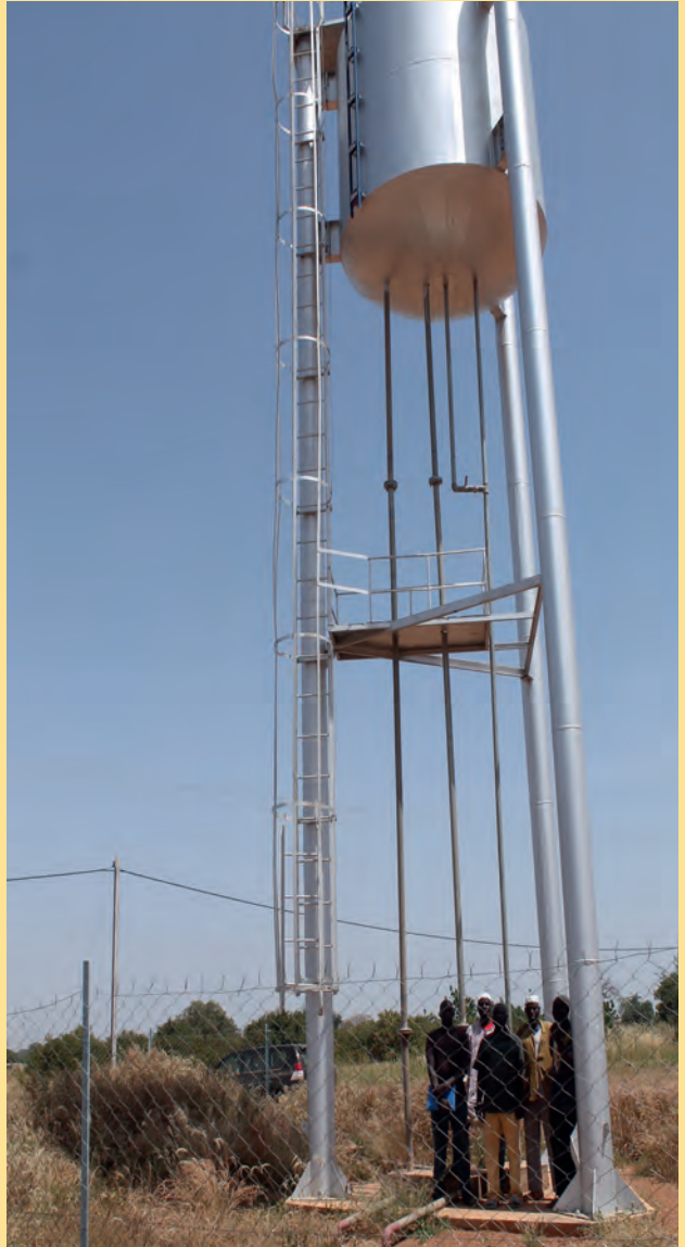
Le nouveau château d'eau de Sawana
